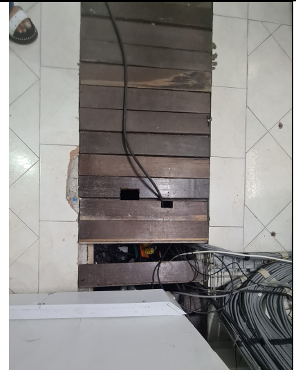
Foto 9: Canal de piso en madera
